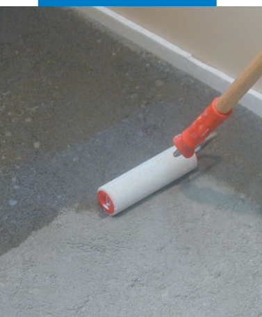
Thi công Primer G bằng rulo lăn
