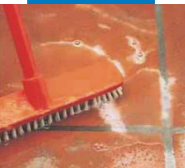
Thi công Keranet dạng lỏng bằng chổi
