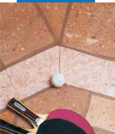
Sàn gạch terracotta đánh bóng tại chỗ được chít mạch bằng Keracolor GG trộn với Fugolastic
