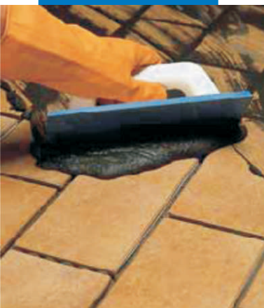
Chít mạch cho sàn gạch klinker bằng Keracolor GG trộn với Fugolastic
