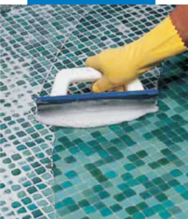
Chít mạch cho mosaics thủy tinh bằng Keracolor FF trộn với Fugolastic
