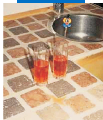
Hình ảnh ốp lát gạch và chít mạch cho bể bếp
