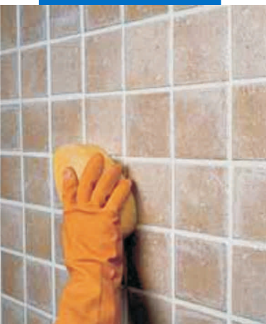
Hoàn thiện tường gạch nung 1 lần bằng miếng bọt biển
