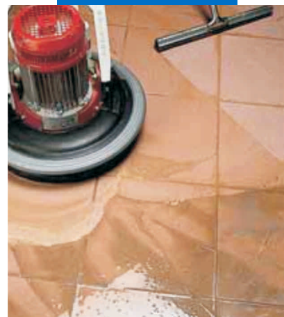
Hoàn thiện sàn gạch porcelain bằng bàn xoa điện hoặc bằng cào cao su
