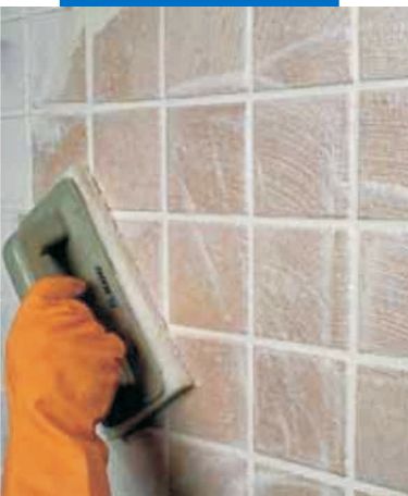
Hoàn thiện tường gạch nung 1 lần bằng miếng Scotch-Brite®
