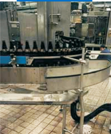
Hình ảnh sàn ở nhà máy bia được chít mạch bằng Kerapoxy
