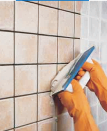
Chít mạch cho tường gạch nung 1 lần bằng bàn xoa
