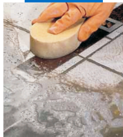
Hoàn thiện sàn gạch ceramic có trang trí gỗ bằng miếng bọt biển
