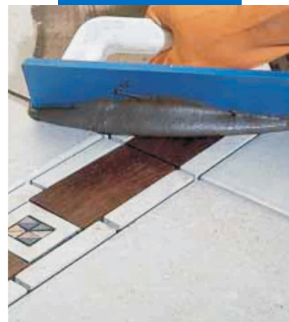
Dùng bay chít mạch cho sàn gạch ceramic có trang trí gỗ
