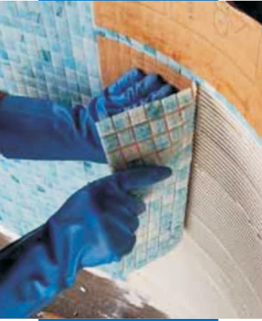
Óp lát gạch mosaic thủy tinh kích thước 2x2 cm bằng Adesilex P10 trộn với Isolastic đã pha loãng với nước theo tỷ lệ 1:1
