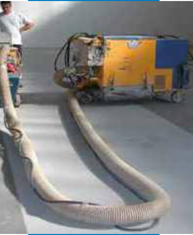
Chuẩn bị bề mặt thi công bằng phương pháp bắn cát
