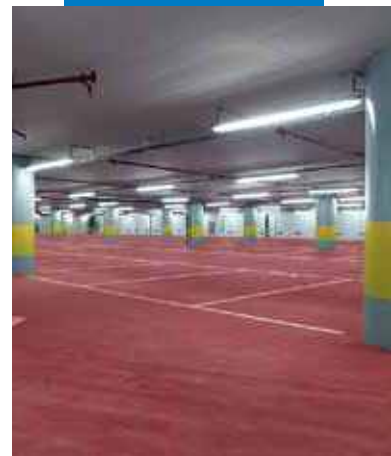
Hình ảnh sàn ở Tòa nhà Berlaymont - Brussels được thi công bằng Ultratop màu đỏ
