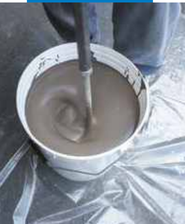
Trộn sản phẩm bằng máy khoan có gắn cánh trộn
