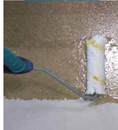
Hiệu ứng “ Terrazzo alla veneziana ”. Thi công Mapecrete I 910
