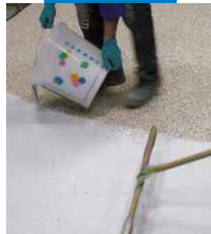
Thi công Ultratop trên bề mặt vữa cốt liệu tự nhiên + Mapecrete I 910 đã đông rắn
