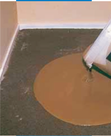
Thi công hỗn hợp vữa Novoplan 21 lên trên bề mặt
