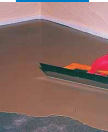
Thi công Novoplan 21 bằng bay kim loại lên trên vữa góc xi măng đã được sơn lót bằng Primer G
