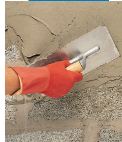
Thi công Planiseal 88 bằng bay
