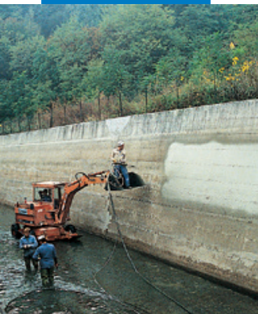
Thi công Planiseal 88 cho kênh thủy điện bằng phương pháp phun
