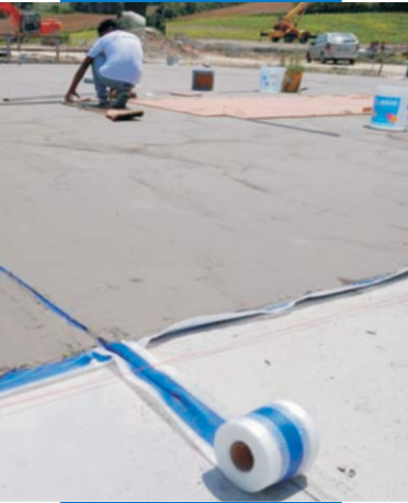
Chống thấm lớp vữa láng nền bằng Mapelastic kết hợp với Mapeband
