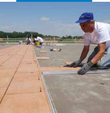
Ốp lát gạch ceramic sử dụng Kerabond + Isolastic
