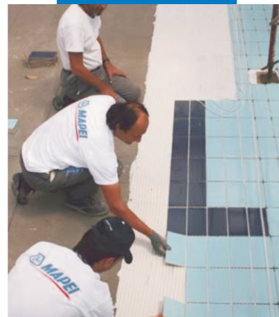
Ốp lát gạch ceramic trên lớp Mapelastic ở bể bơi
