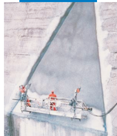
Hình ảnh Mapelastic được thi công chống thấm cho đập bê tông phương pháp phun
