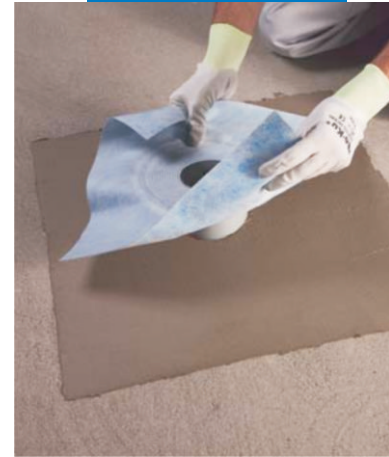
Lắp đặt ống dẫn nước trên Mapelastic
