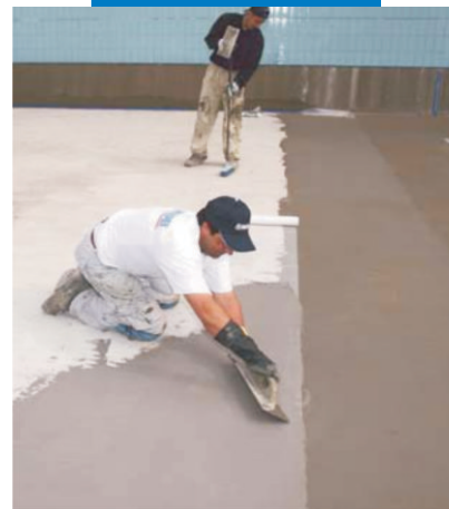
Chống thấm cho bể bơi sử dụng Mapelastic
