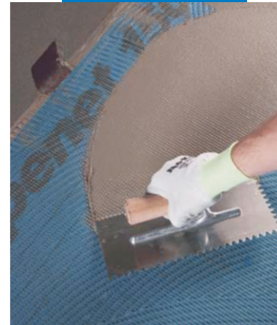
Thi công Mapelastic trên Mapenet 150
